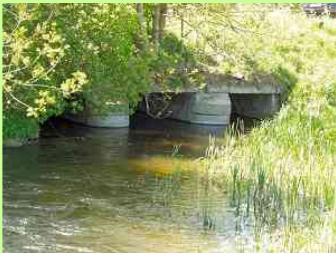
Brücke über Kongsvad Mølleå bei Holmegård. Die Brücke wurde in 1835 gebaut - aus Granitquadern der niedergelegenen romanischen Kirche in Karlby, wo es auch eine Heiligquelle gab.
